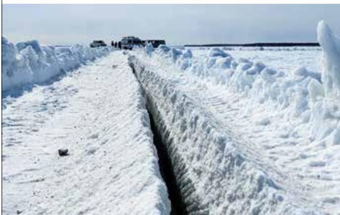
Распиловка льда – эффективный метод разрушения льда
