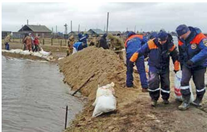
Временная дамба возводится с использованием местного грунта
